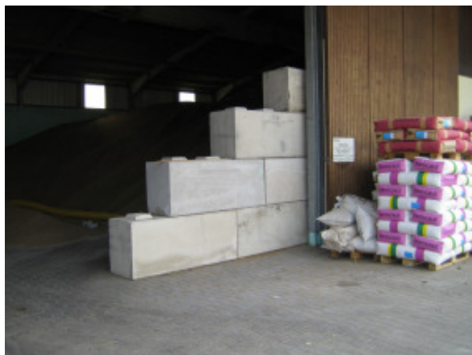
Erweiterung einer Lagerfläche im Torbereich einer Kornhalle
