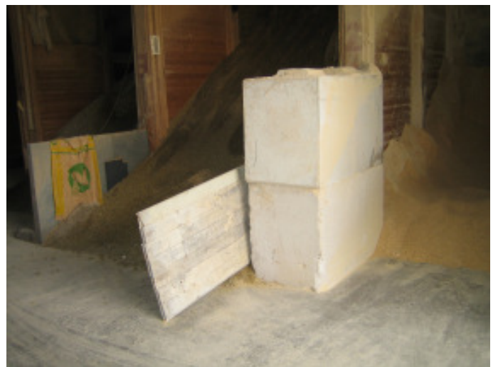
Erweiterung einer Lagerfläche mit Big-Block-Steinen
