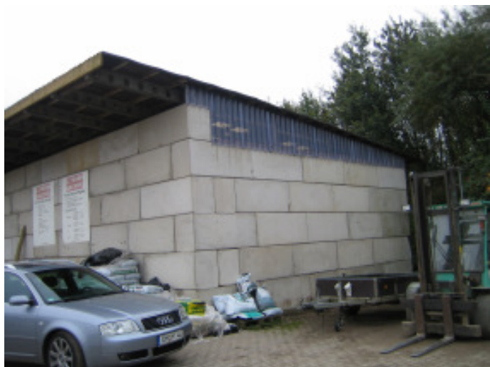
Lagerhalle aus Big-Block Elementen
