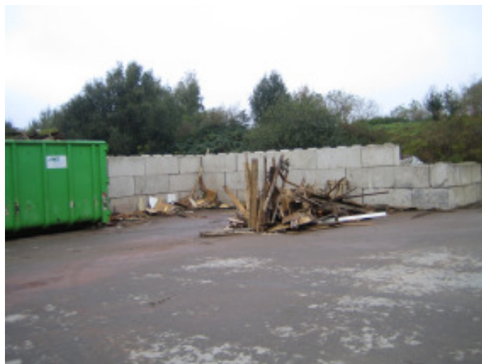
Holzlager: Eingrenzung durch Big-Block-Steine
