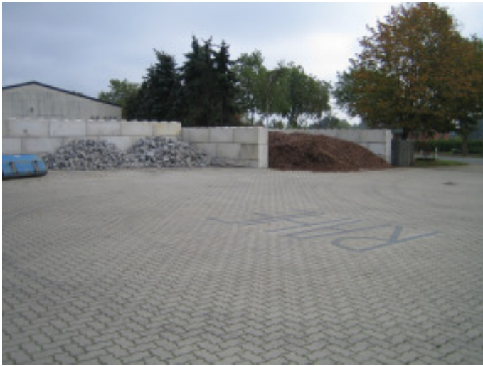
Lagerfläche eines Gartenbetriebes durch Big-Block-Steine
