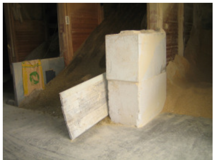
Erweiterung einer Lagerfläche mit Big-Block-Steinen
